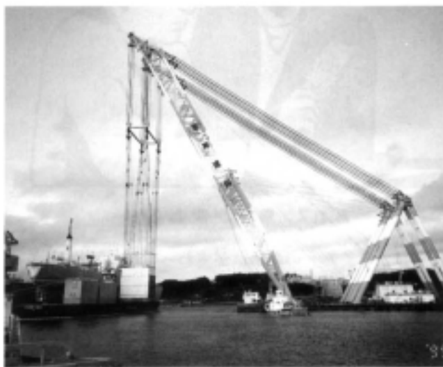
写真2 原子炉室移送
